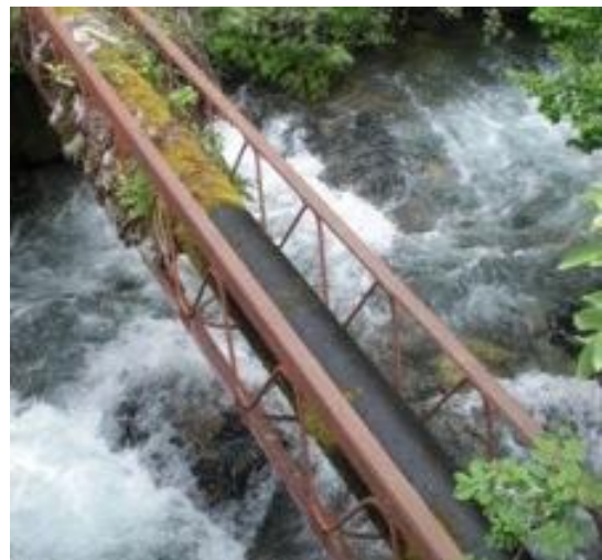
Слика 7-44 Водоводот кон Дебар поминува преку Росочка река, под мостот
